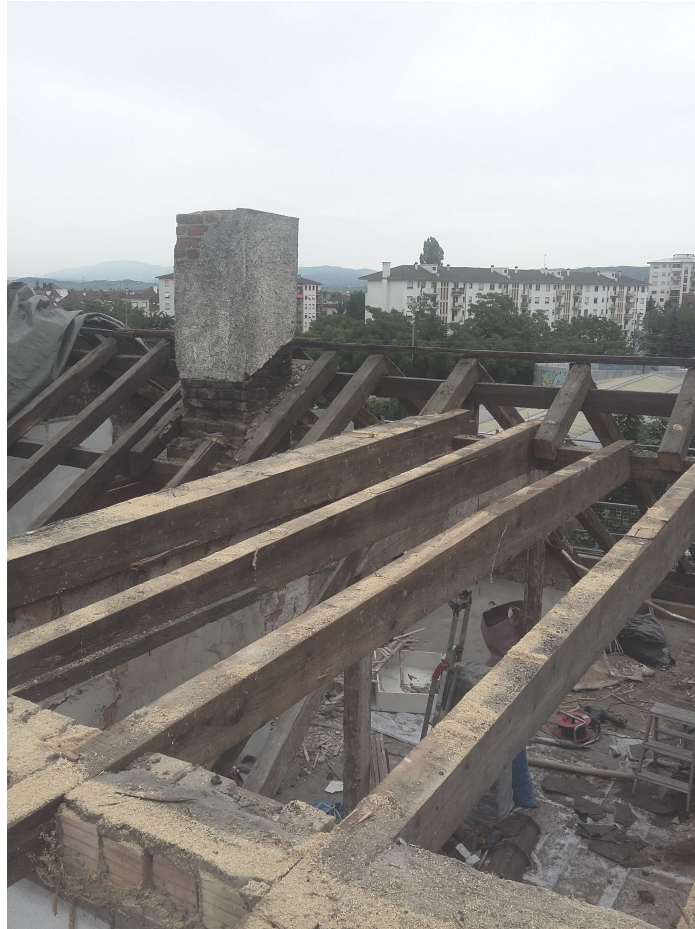
Rückbau alter Dachstuhl
