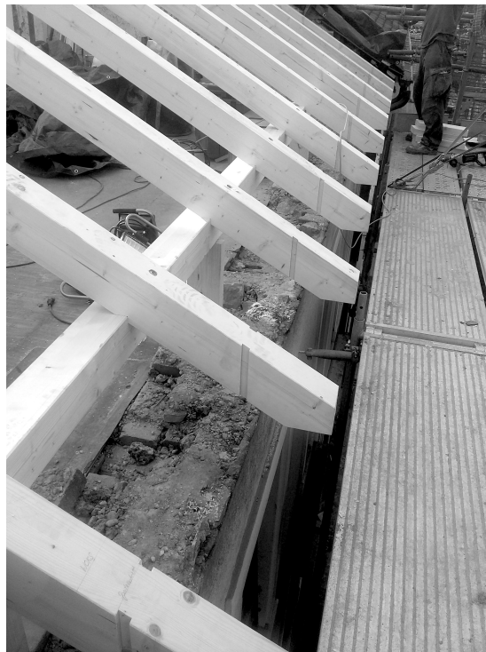
Aufrichten neuer Dachstuhl
